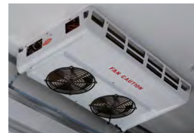
더블 냉동기 (4+2 FAN)
