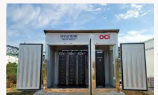
OCI 공장의 상업용 300kWh ESS
