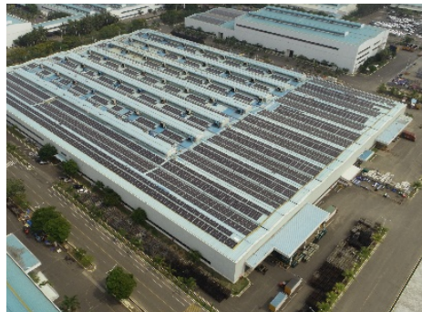
인도생산법인 태양광 발전시설
